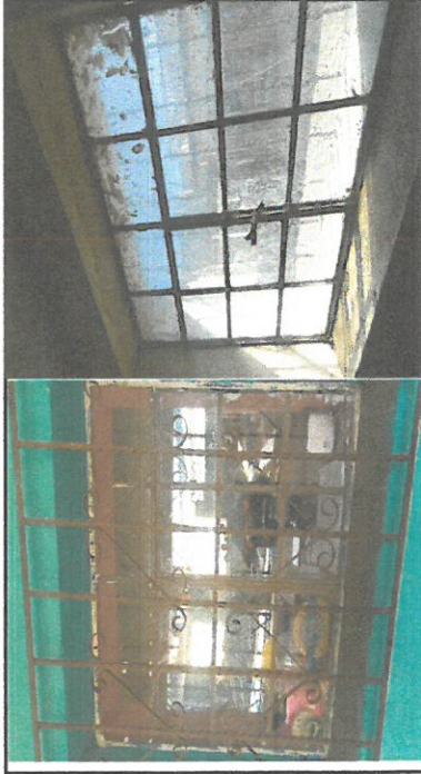
Foto 1: Cambio de ventanas en el modulo 1
